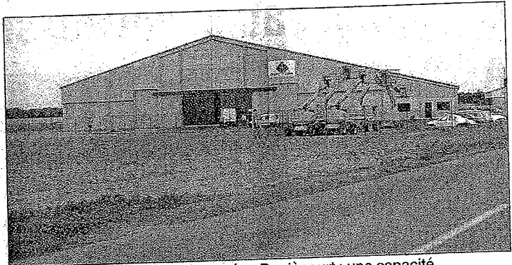
Les nouvelles installations d'Estrées-Deniécourt : une capacité de stockage de 3000 tonnes d'engrais.
